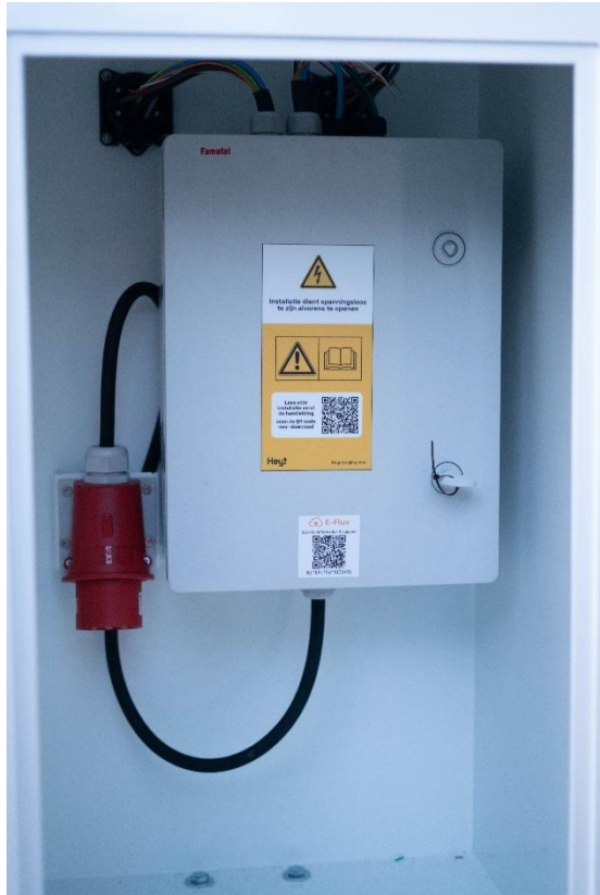
Figuur 3 aansluiting voedingskabel laadpaal
