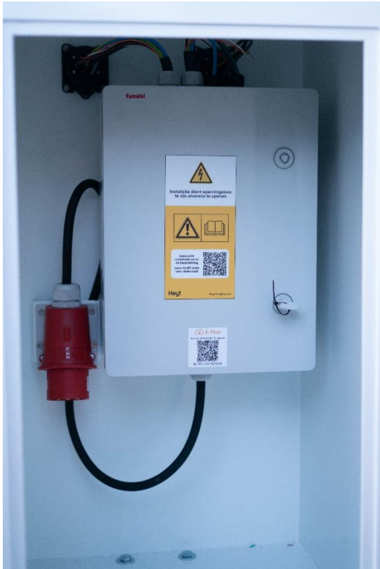
Figuur 1 aansluiting voedingskabel laadpaal
